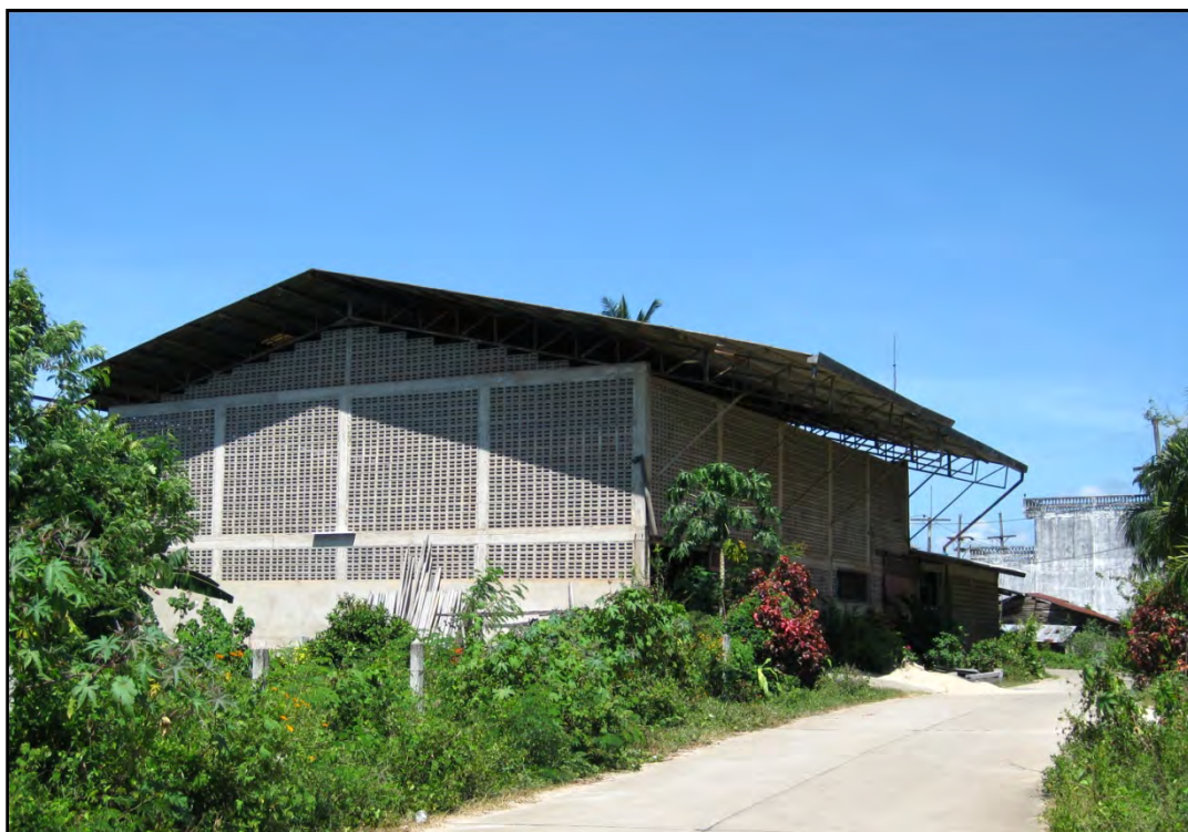
ภาพ 12 – 13 : โรงมยางพารา: โรงมยางพาราขนาดเล็ก สิ่งก่อสร้างแฝงไว้ซึ่งความทรงจำในความผูกพัน ระหว่างชาวจีนฮกจิวกับกิจกรรมเกี่ยวเนื่องกับสวนยางพาราของพวกเขา ในภาพ 12 เห็นได้ถึง ลักษณะการก่อสร้างโรงมยางพาราที่ยกพื้นให้ไม้ได้ถุนเตี้ยใช้เป็นเตาไว้รมควันยางพาราแผ่น
