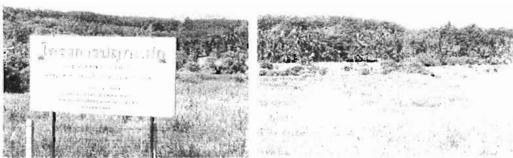
รูปที่ 43 44 45 และ 46 บริเวณด้านล่างอ่างเก็บน้ำ
