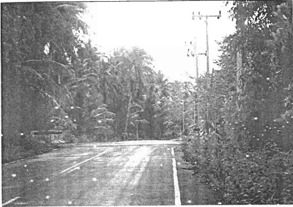
ภาพประกอบ 8 แสดงสะพาน ถนนลาดยาง ไฟฟ้า ของตำบลบางไผ่
