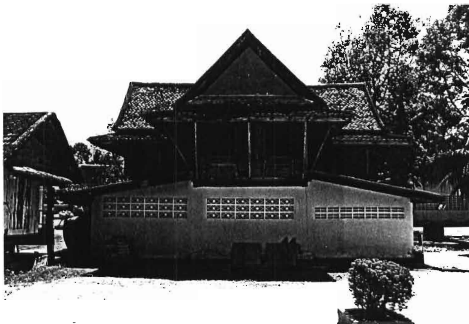
ภาพประกอบ 110 คณะภิกษุ 2 ชั้น มีห้องพัก 3 ห้อง ชั้นบนเป็นชั้นลอยวัดดีหลวงโน ตำบลชิงโค อำเภอสิงหนคร จังหวัดสงขลา
