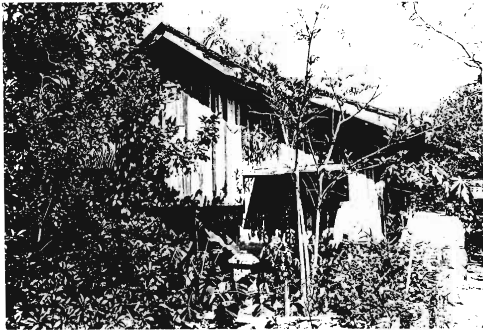
ภาพประกอบ 37 ฝาผนังไม้กระดานตีทับแนวตามแนวตั้ง วัดบางเขียด ตำบลบางเขียด อำเภอสิงหนคร จังหวัดสงขลา
