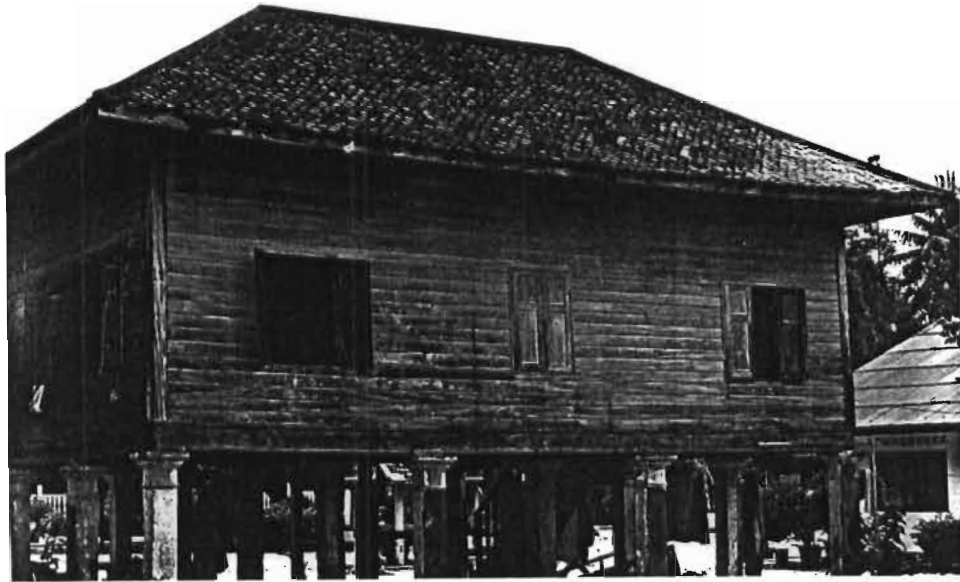
ภาพประกอบ 35 ฝาผนังไม้กระดานตีซ้อนเกล็ดตามแนวนอน วัดดีหลวงใน ตำบลชิงโค อำเภอสิงหนคร จังหวัดสงขลา
