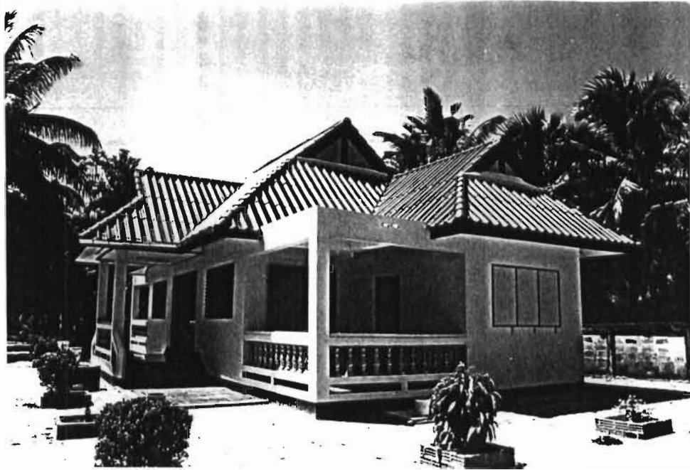
ภาพประกอบ 105 ภูมิหลังคาแบบบลานอ วัดดีหลวงโน ตำบลชิงโค อำเภอสิงหนคร จังหวัดสงขลา
