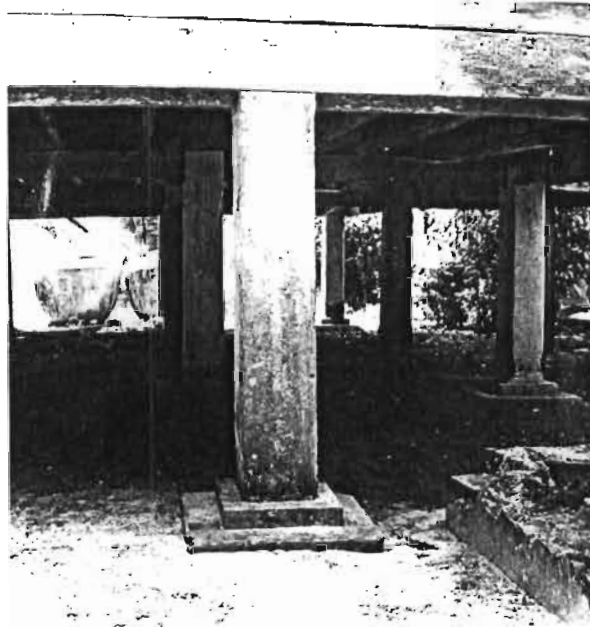
ภาพประกอบ 16 ตีนเสาคอนกรีตแบบมีฐานสูงถึงใต้ท้องคาน วัดสี่หยัง ตำบลบ่อตรุ อำเภอระโนด จังหวัดสงขลา
