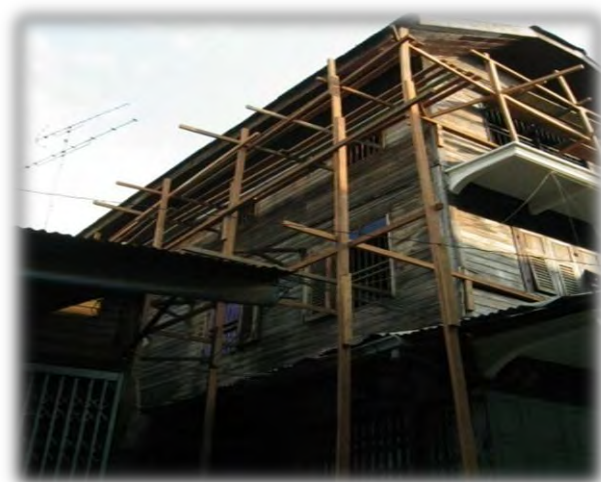
ภาพที่ ๓๘ การปรับปรุงอาคารบ้านขุนจันจันรักย์
