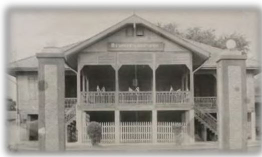
ภาพที่ ๗ ที่ว่าการอำเภอสามชุกในอดีต
