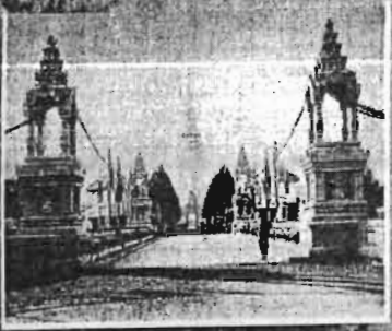
สะพานใจเวญสุรทธา เดิมเป็นสะพานไม้ ข้ามคลองเจ้าบุญรา ากฝั่งตตาวัดโพมัยองคค์พระมรุณใจลลปี พระบาทสมเด็จพระมงกุฎเกล้าเจ้าอยู่หัว รัชกาลที่ 6 โปรดเกล้าฯ ให้สมเด็จเจ้าฟ้ากรมพระยานริศรานุวัดติวงศ์ทรงออกแบบสร้างใหม่เมื่อ พ.ศ. 2461 นับเป็นสะพานปูนแห่งแรกของจังหวัดนครปฐม (ภาพจากจดหมายเหตุแห่งชาติ)
