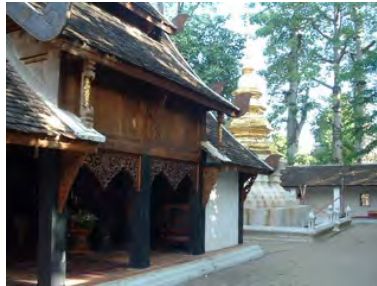
รูปที่ 1.5 อาคารเลียนแบบ วิหารวัดไหล่หินหลวง (สร้างในโรงแรม)
