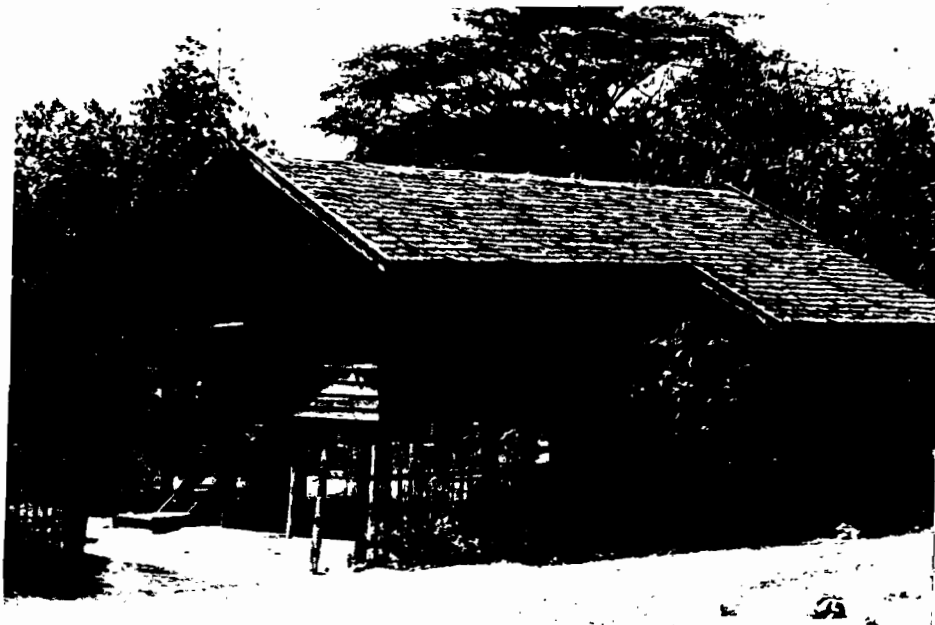
2 เรือนไม้สัก หลังคามุงแป้นเกล็ด ชนบทลำปางทั่วไป ถ่ายที่ อ.แจ้ห่ม จ.ลำปาง
