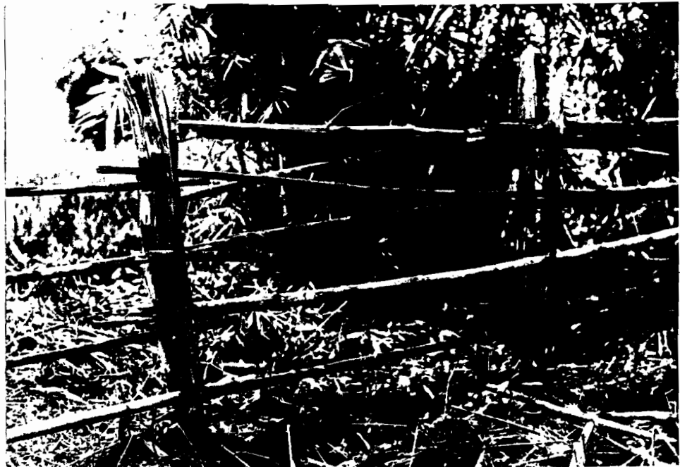
ภาพที่ รี่วตั้งบ่อง เคร่าไม้ไผ่ ตามหมู่บ้านภาคเหนือทั่วไป ปกติใช้เคร่าไม้สักผ่าซีก
