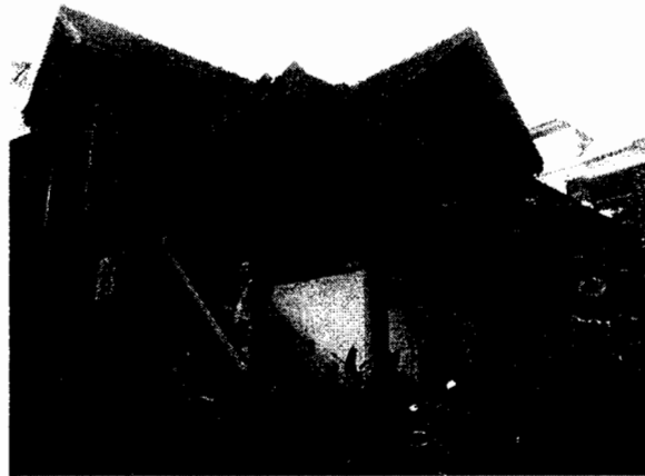
ภาพที่ 4.53 ลักษณะเรือนเจ้าไชยสุริวงศ์ ณ เชียงใหม่ วงศ์เจ้าพ่อของเจ้าธวัชวงศ์ ณ เชียงใหม่ เป็นลักษณะเรือนไม้ได้ทุนสูง หลังคาสูงทรงมะลิลา มีระเบียง ด้านหน้าและด้านข้าง เรือนแบบหลังคาคุมบันได บันไดแบบล้านนา ลวดลายขลุ่ยลายเคลือเถา ตกแต่งแบบศิลปะพม่า ที่มา : ชัชวาลย์ ธรรมสอน, 2549
