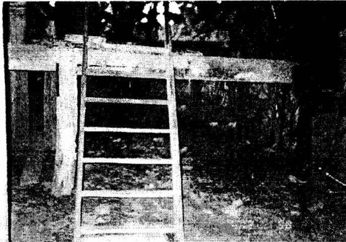
ภาพที่ 2.16 แสดงลักษณะบันไดเป็นขั้นคี่ 7 ขั้น ชั้นบนสูงกว่าฐานเล็กน้อย ชั้นล่างสูงกว่าพื้น 1 คืบ
