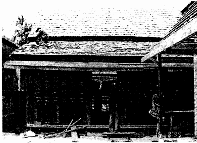
ภาพที่ 2.27 แสดงสภาพโครงสร้างเรือนมณิลาและบานเพ็ชรมังใช้การได้ดี ขณะกำลังทำการซ่อมแซม เป็นอนุรักษ์เรือนไทยให้คงอยู่ต่อไป เรือน กำแพงเพชร เรือนเมืองระแหง ในอดีตไม่มีการมุงด้วยแป้นเกร็ด ที่มา : ชัชวาลย์ ธรรมสอน, 2540 : 69
