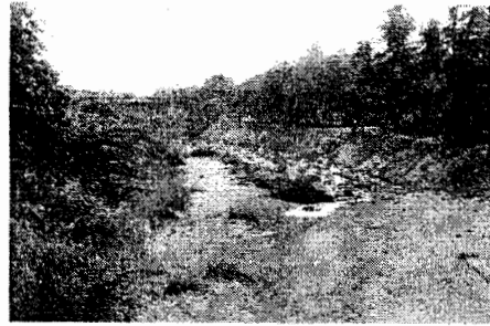
ภาพที่ 3.49 สภาพคลองสวนหมากขณะ กำลังปรับแต่งตลิ่งหน้าเรือนพะโป้ (2547) ที่มา : ถ่ายเมื่อ ธันวาคม พ.ศ.2547
