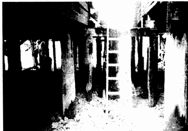
ภาพที่ 2.15 แสดงลักษณะบันไดแบบโบราณ แม่บันไดและลูกนอนมนกลม พร้อมทั้งจะขึ้นลงได้สะดวก
