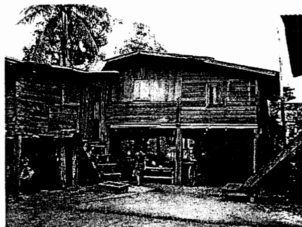
บันไดทางขึ้นเรือนอยู่ระหว่างเรือนเดิม และส่วนต่อเติม
