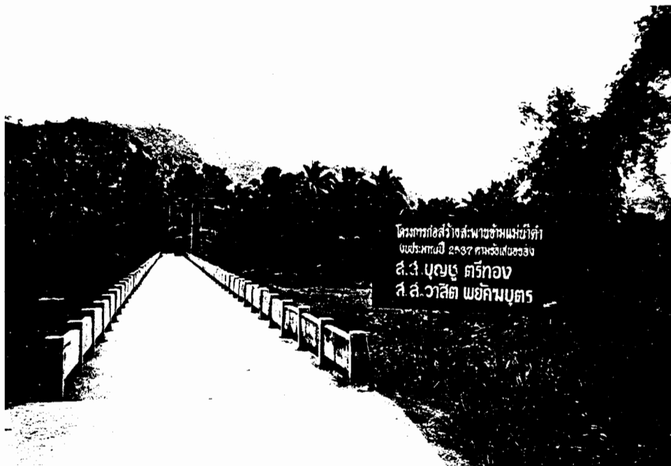
ภาพที่ 2. สะพานคอนกรีตข้ามลำห้วยแม่ต้า เชื่อมระหว่าง บ้านไผ่จามกับบ้านไผ่แพะ
