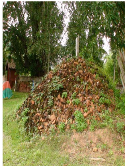
ภาพที่ ๙ กองอิฐ(เจดีย์)ที่พังทลายลง
