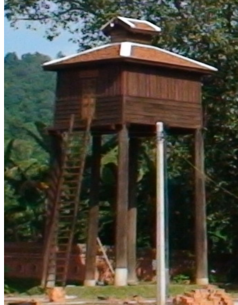
ภาพที่ ๕ หอพระไตรปิฎกหลังบูรณะเสร็จแล้ว
