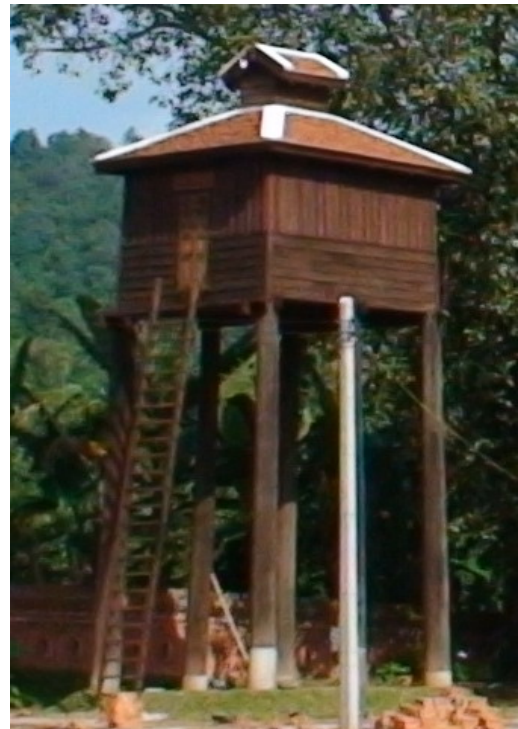
หลังบูรณะเสร็จแล้ว
