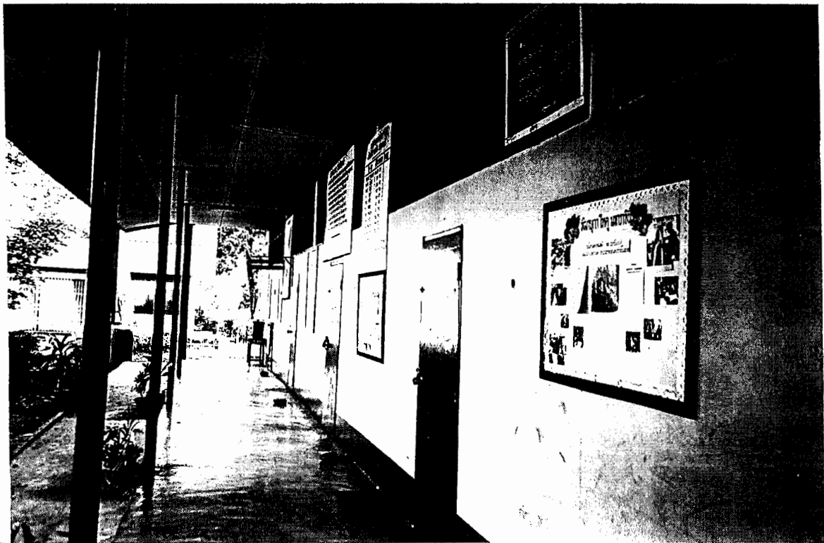
ภาพที่ 10 สภาพอาคารเรียนโรงเรียนบ้านเวินบึก
