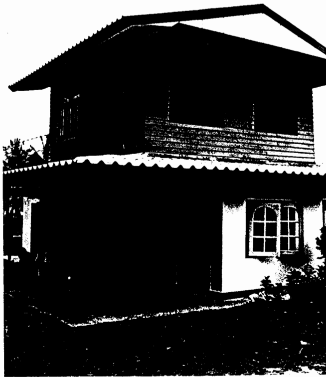
ภาพประกอบ 23 บ้านพักอาศัยของหมอลำ
