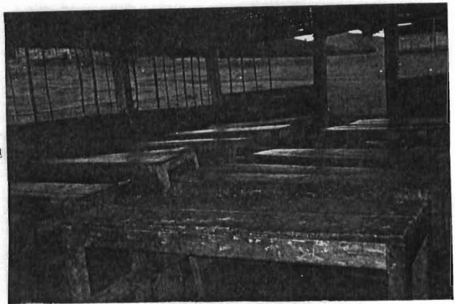
ภายในอาคารเรียน
