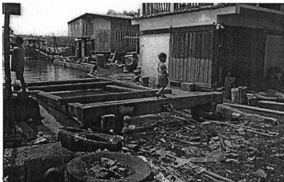
ถาดสี่หรือสี่ สำหรับวางหุ่นตัวลำเรือ มีลวดสลิงชักลากขึ้นคาน
