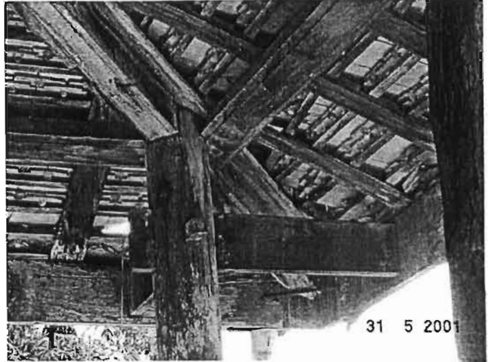
โครงสร้างชายคา ศาลาการเปรียญด้านทิศตะวันออกเฉียงเหนือ
