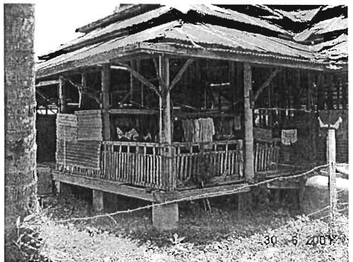
ลูกทรงไม้กันตมมุขศาลาด้านตะวันตกเฉียงใต้
