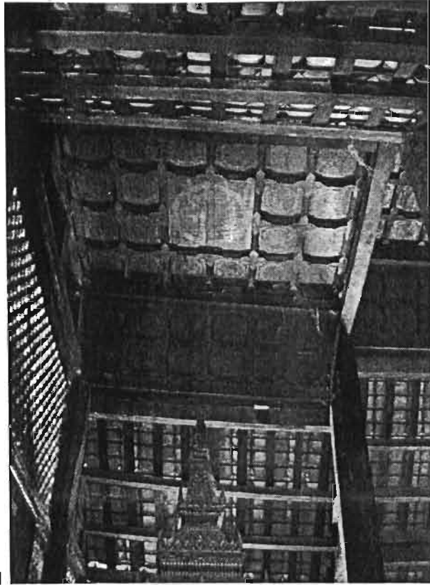
ฝาเพดานภายในบริเวณใต้หลังคาช่วงลดมุข
