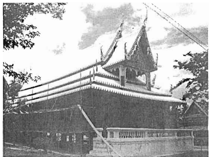
มุมอาคารด้านทิศตะวันตกเฉียงเหนือ
