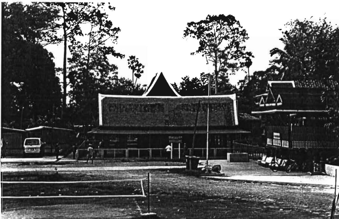
ศาลาดินและบริเวณลานวัด วัดสิงห์ หมู่ 2 ตำบลสามโคก อำเภอสามโคก จังหวัดปทุมธานี
