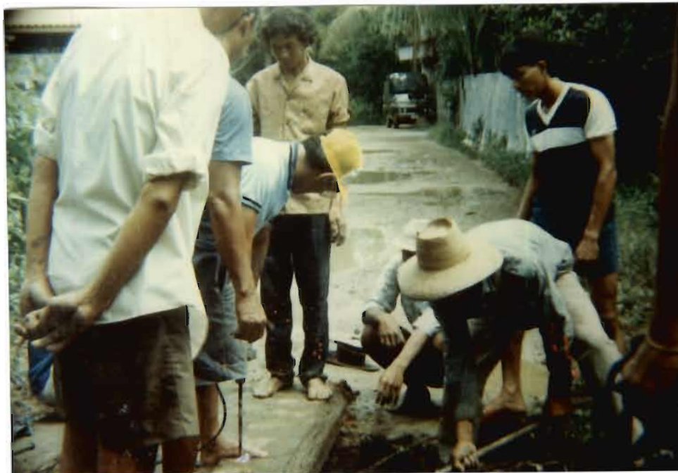
ภาพประกอบ 25 ซ่อมแซมถนนหนทาง
