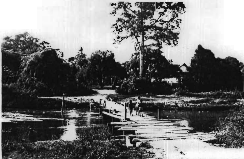
ภาพที่ 6 สะพานชั่วคราวที่ใช้ในการสำรวจปัจจุบัน (2534)
