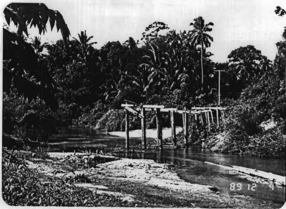
ภาพที่ 5 สะพานข้ามลำน้ำที่ยังใช้จากไม่ได้
