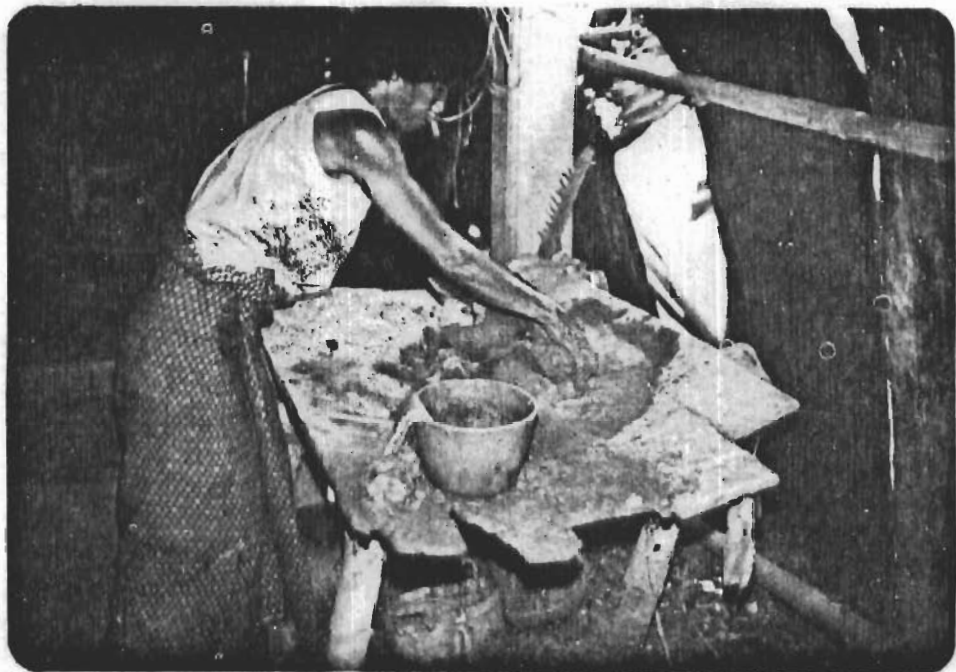
๑๘. การผสมดินท่อน้ำฝนอยู่ตลอดเวลา และค่อย ๆ ผสมดินกับทรายเข้าด้วยกัน
