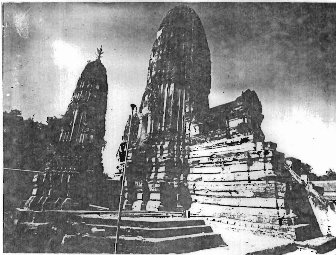
ภาพที่ 8 ปรางค์ประธานวิฆเนศวร จันทบุรี ฐานก่อด้วยศิลาแดง องค์ปรางค์ก่ออิฐสอดกั้น ด้วยระบบอิงลิชคอนกรีต
