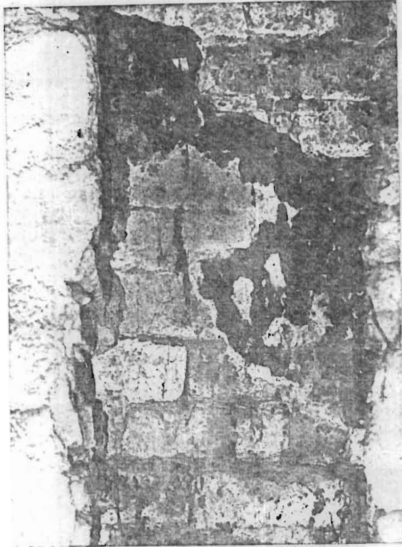
ภาพที่ 75 ร่องรอยครายสีน้ำทองแดงบนผนัง แกะก่อนการ เติมหอกผนัง ภายในคูหาปราสาทประธาน วัดพระธรรม
