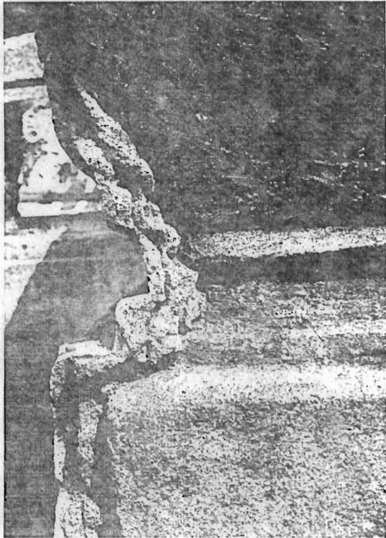
ภาพที่ 71 ร่องรอยการพอกปูนเพิ่มเติมอย่างน้อย 3 ครั้ง บนองค์ปรางค์
