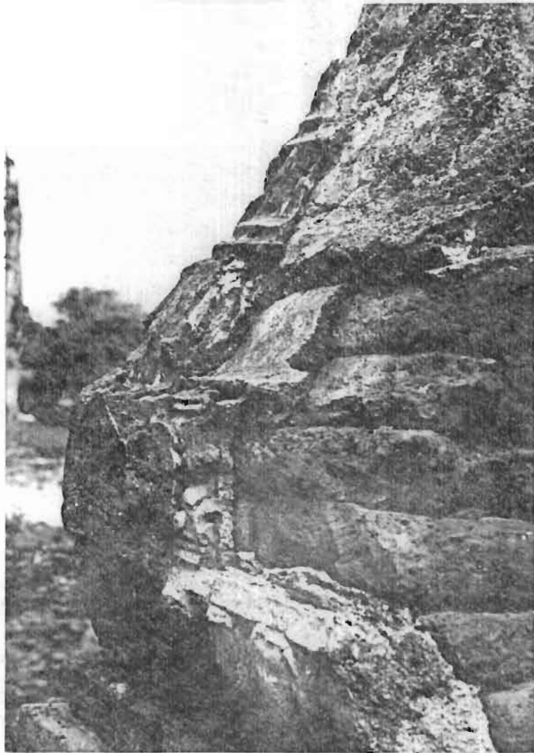
ภาพที่ 81 ร่องรอยการพอกทับเพิ่มเติมของคปรางค์อย่างน้อย 3 ครั้ง
