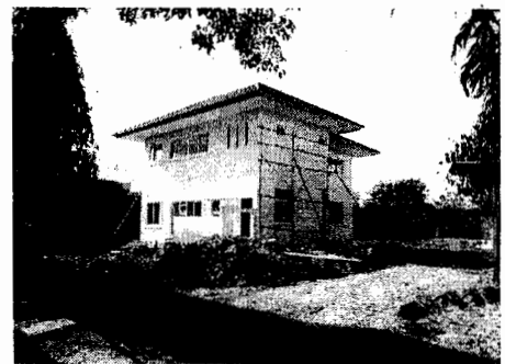
การก่อสร้างหมู่บ้านจัดสรร
